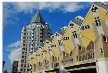
キューブハウス
