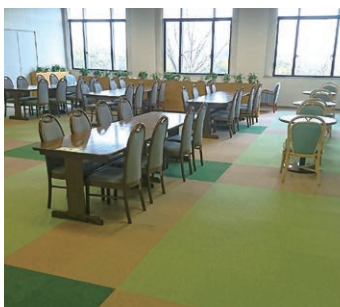
2階食堂カーペット貼り換え後
