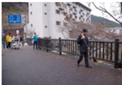
施工前の遊歩道
